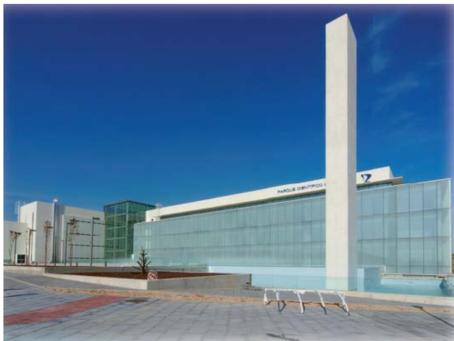
Edificio central del Parque Científico de Madrid (Cantoblanco)
